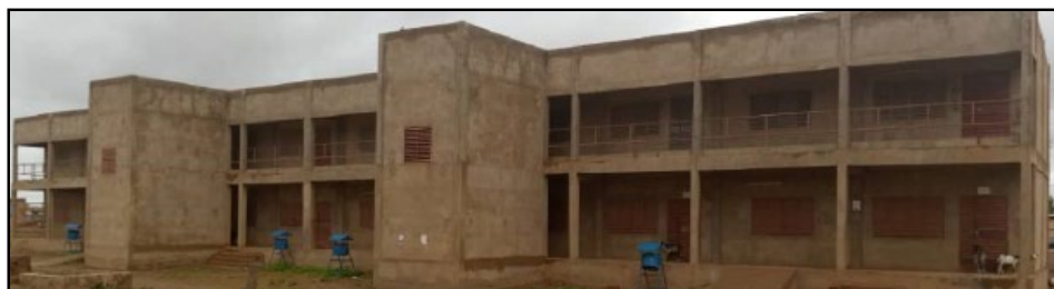
Le Groupe scolaire EDP de Kaya : un chantier mis en œuvre sur fonds propres.
